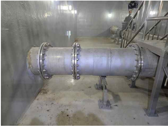
손상내용 유입밸브실 송수관로 상태양호 손상원인 -
