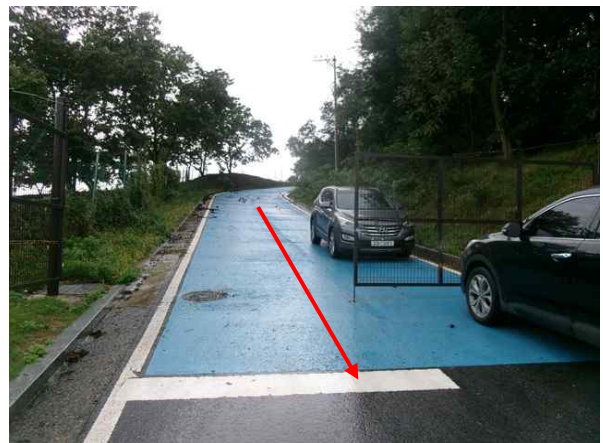
위 치 송수관로 (Sta.17+1.5) 손상내용 포장 및 지반 상태양호
