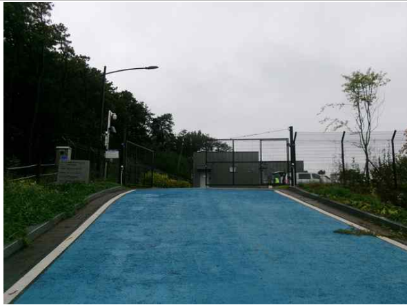
송수관로 시점부 전경
