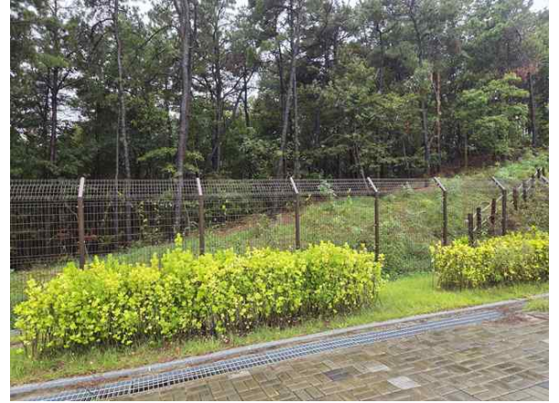
손상내용 안전휀스 상태양호
