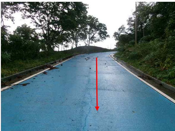
위 치 송수관로 (Sta.14+15.8) 손상내용 포장 및 지반 상태양호
