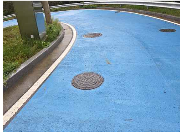
위 치 송수관로 점검구(B1-1) 손상내용 맨홀 덮개 상태양호
