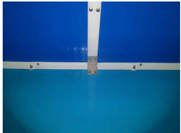
손상내용 2지 도류벽 볼트체결 상태양호 손상원인 -
