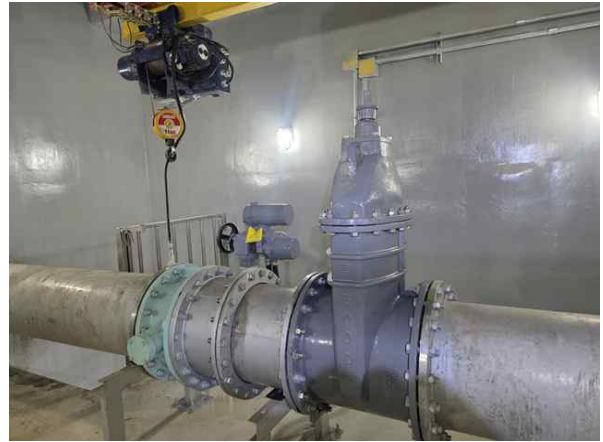
손상내용 유입밸브실 유입밸브 상태양호 손상원인 -
