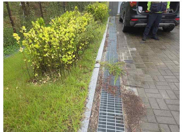
손상내용 배수시설 상태양호
