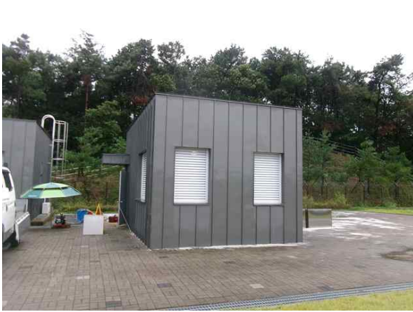
손상내용 전기실 외부 상태양호 손상원인 -
