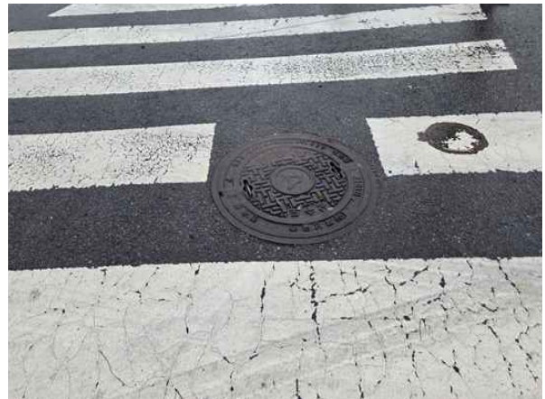
위 치 송수관로 점검구(B1-2) 손상내용 맨홀 덮개 상태양호
