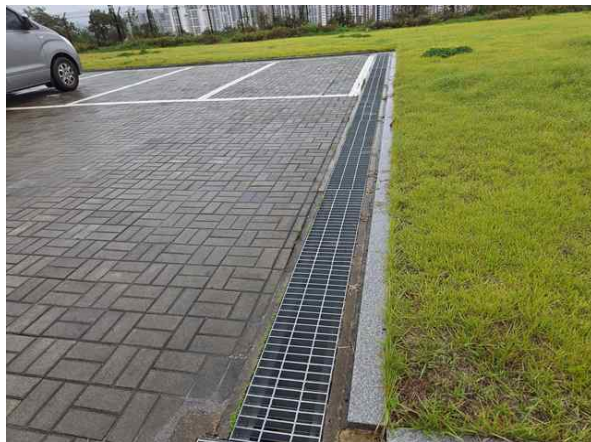
손상내용 배수시설 상태양호
