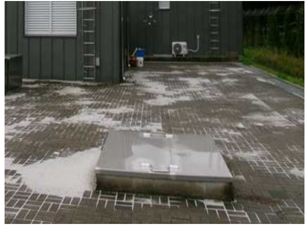
환기구 등의 덮개(장비 반입구) 현황
