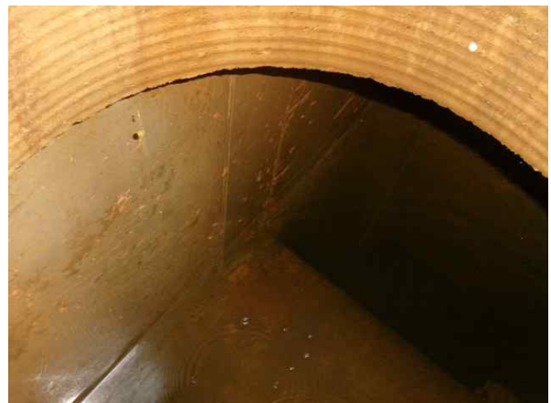
위 치 송수관로 Sta.17+1.5(점검구) 손상내용 벽체 상태양호
