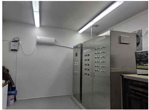
손상내용 전기실 내부 상태양호 손상원인 -
