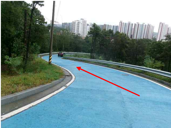
위 치 송수관로 (Sta.4+0.0) 손상내용 포장 및 지반 상태양호
