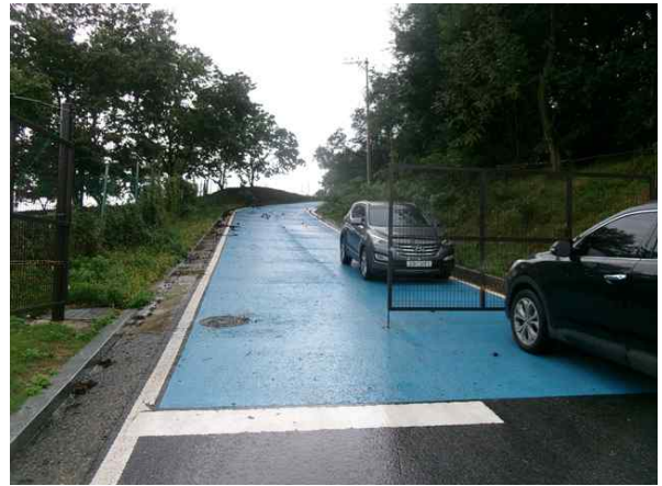
송수관로 종점부 전경
