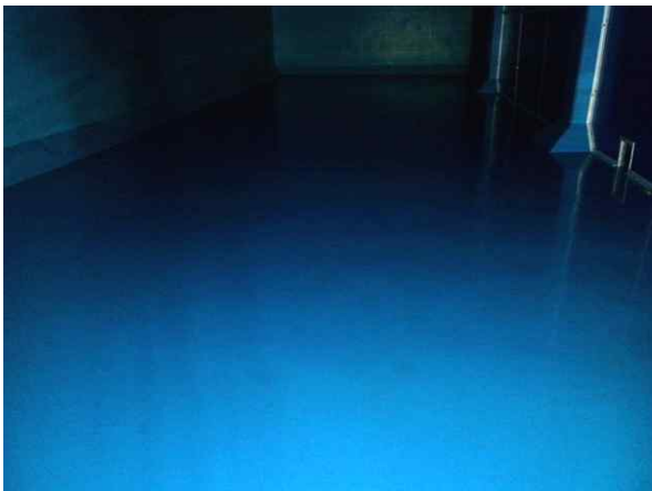
손상내용 2지 바닥슬래브 상태양호 손상원인 -
