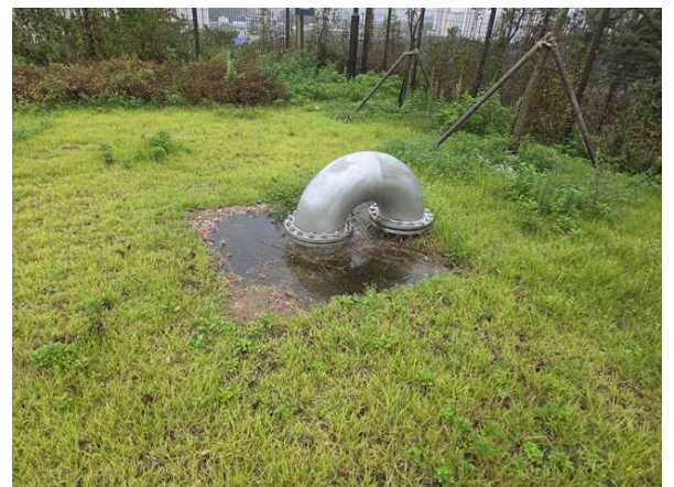
손상내용 환기구 상태양호
