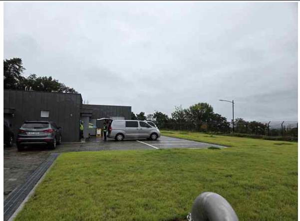
배수지 상부 현황
