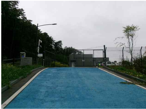
송수관로 시점부 전경
