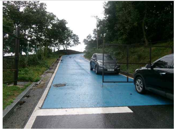
송수관로 종점부 전경
