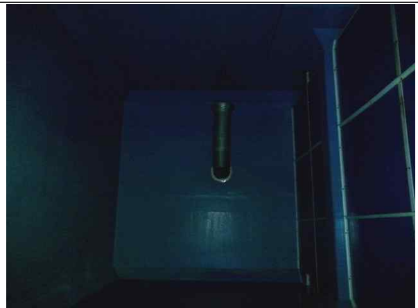
배수지 2지 내부 전경
