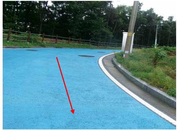
위 치 송수관로 (Sta.3+16.1) 손상내용 포장 및 지반 상태양호
