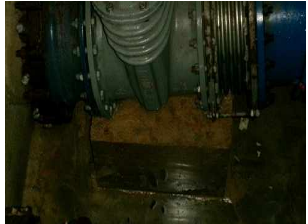
위 치 송수관로 Sta.4+0.0(유량계실) 손상내용 기초 상태양호
