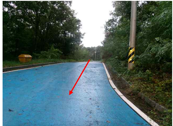
위 치 송수관로 (Sta.7+16.7) 손상내용 포장 및 지반 상태양호
