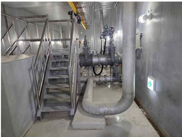
손상내용 유출밸브실 송수관로 상태양호 손상원인 -
