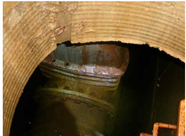
위 치 송수관로 Sta.17+1.5(점검구) 손상내용 도장 상태양호
