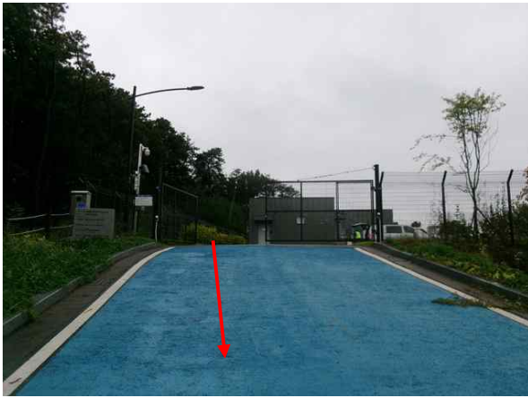
위 치 송수관로 (Sta.1+9.0) 손상내용 포장 및 지반 상태양호
